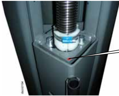
Bild 16: Tragmutterstift mit rotem Sicherungsack versehen
